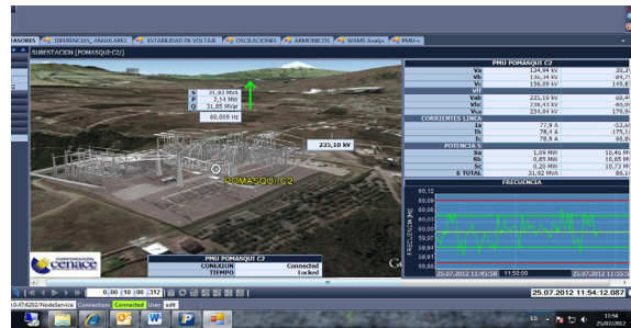
Figura 12: Despliegue de Subestación
