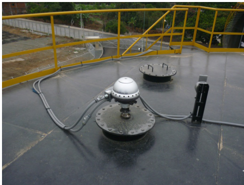
Figura 2: Sistema medición implementado para medición de combustible en Tanques
