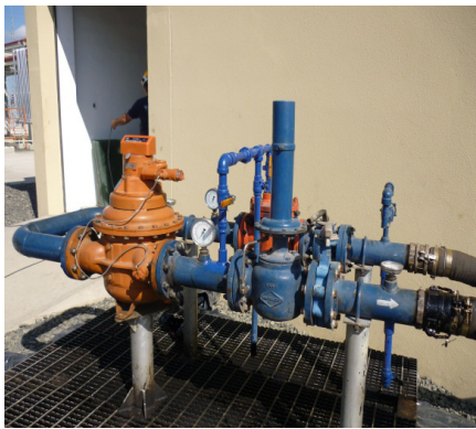
Figura 4: Probador Volumétrico para calibración de sistemas de medición dinámicos
