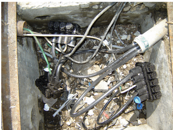
Figura 5: Implementación de puertos de gel en las conexiones de acometidas y derivaciones de circuitos en las redes subterráneas de baja tensión
