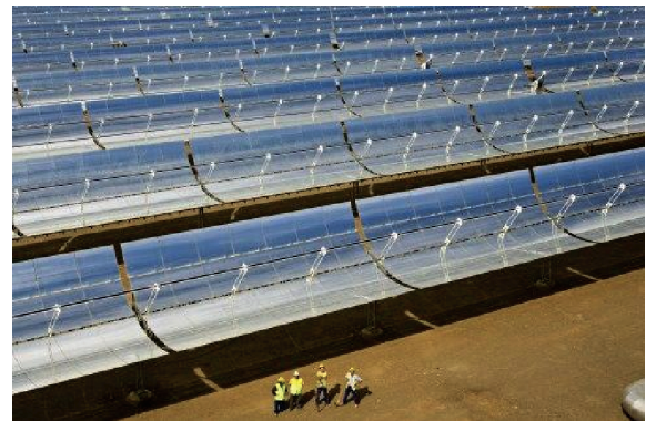
Figura 3: Central Eléctrica Híbrido Solar-Gas
