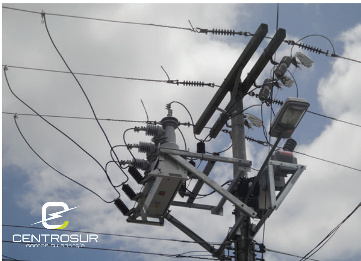
Figura 3: Reconector Automatizado
