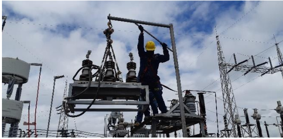
Figura 4: Colocación de reconectador en patio de la subestación eléctrica Novacero S.A.
